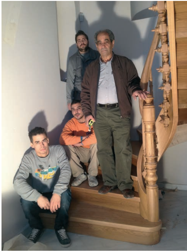
Κλιμακοστάσιο κεντρικό τμήμα/Διαδικασία κατασκευής/Λεπτομέριες Κρεμαστή κουρμπανιστή μασίφ Δρύινη σκάλα με δρύινη κουपाστή και κάγκελο ειδικής κατασκευής χειροποίητο.
