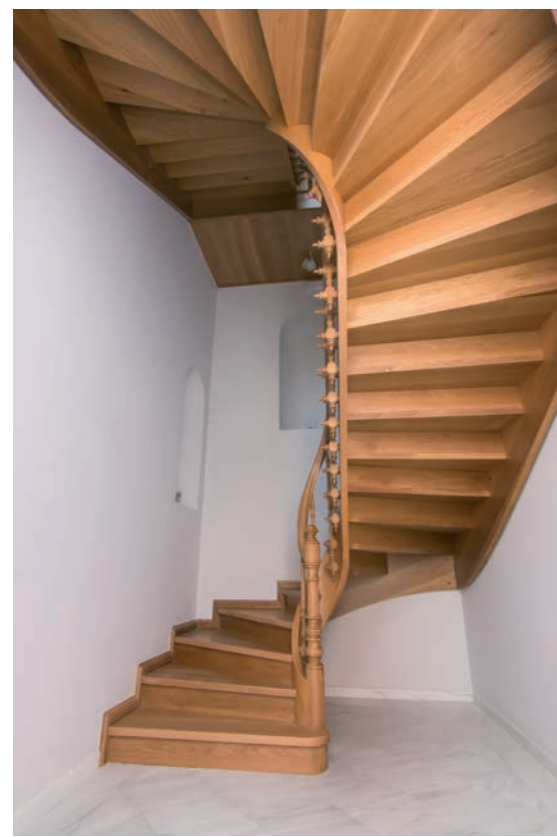
Κλιμακοστάσιο κεντρικό τμήμα/Διαδικασία κατασκευής/Λεπτομέριες Κρεμαστή κουρμπανιστή μασίφ Δρύινη σκάλα με δρύινη κουपाστή και κάγκελο ειδικής κατασκευής χειροποίητο.
