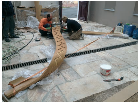
Κλιμακοστάσιο κεντρικό τμήμα/Διαδικασία κατασκευής/Λεπτομέριες Κρεμαστή κουρμπανιστή μασίφ Δρύινη σκάλα με δρύινη κουपाστή και κάγκελο ειδικής κατασκευής χειροποίητο.
